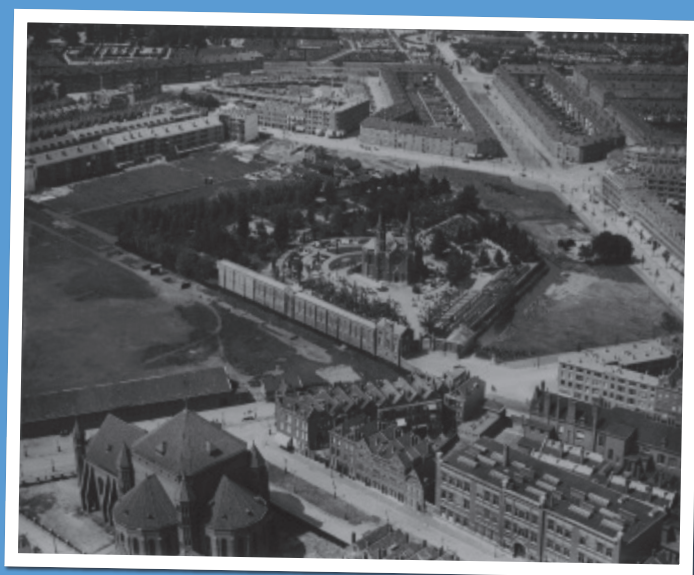
Luchtfoto uit 1923, met in het midden achteraan duidelijk zichtbaar de net gebouwde 'Slurf' (foto: Stadsarchief Rotterdam)
