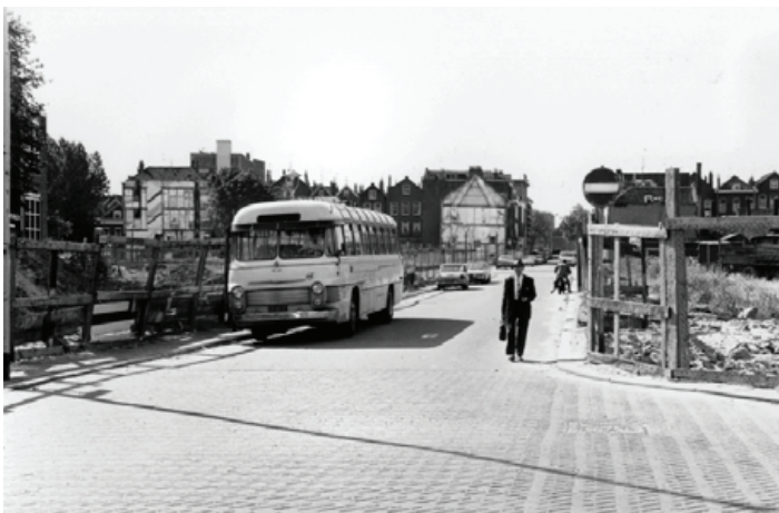
Een groot deel van de Dirk Smitsstraat is gesloopt, 1972
